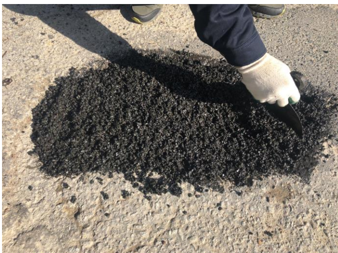
補修材の敷設(施工方法⑤)
