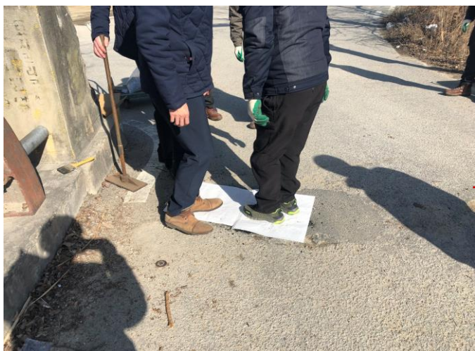
補修材の転圧(施工方法⑤)
