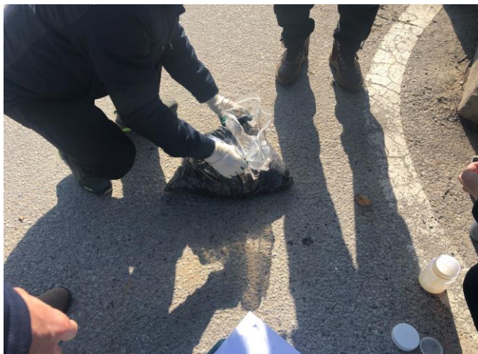
アストロンガーと常温合材の混合(施工方法④)
