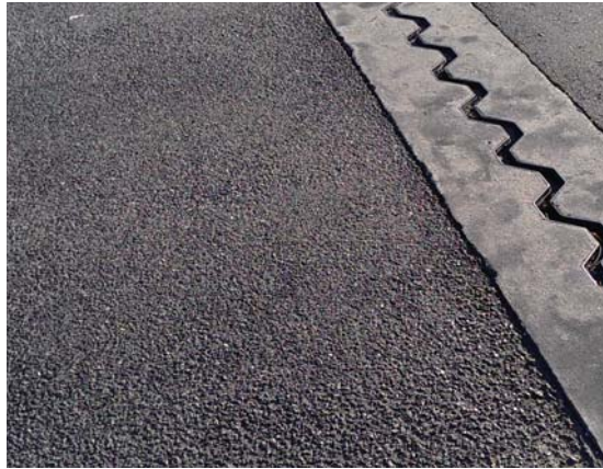
橋梁ジョイント段差修正
