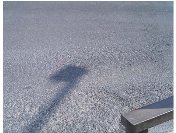
骨材飛散し荒れた路面の補修
