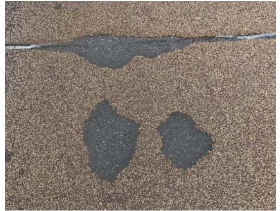
カラー舗装の補修
