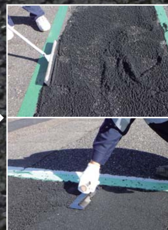
材料をレーキやコテで 敷き均す
