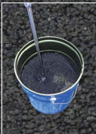
混合したバインダ樹脂を 骨材缶に入れ混合
